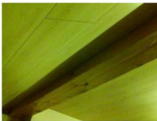
Wyraźna inflirtacja zimnego powietrza na krawędzi połączenia belki z wykończeniem sufitu.
